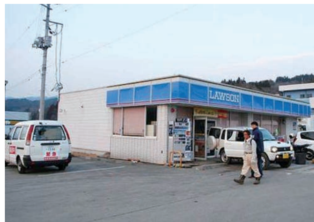
からうじて原形をとどめていた気仙沼東八幡前店。左は先遣隊として店舗の被災状況を見て回った江口啓司
